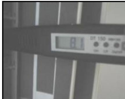
Asegurarse de que la diferencia de temperaturas entre la descarga y retorno sea mayor a 8°C (Enfriamiento) & 14°C(Calefaccion)
