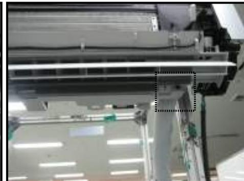
Despues de retirar los 3 tornillos, remueva completamente las parte de la descarga de la unidad.
